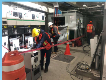
Mantenimiento a Subestaciones Eléctricas
